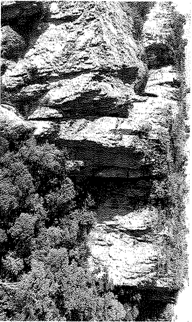
Figura 3.5.2-16. Detalhe da zona C2.2, onde observa-se diversas colunas de rocha com até 50 m de altura, intensamente fraturadas e inclinadas em direção a represa, indicando o início do processo de tombamento. Medidas de contingenciamento do perigo são altamente recomendadas, incluindo a elaboração e execução de projeto de recuperação e estabilização de todo este compartimento.
